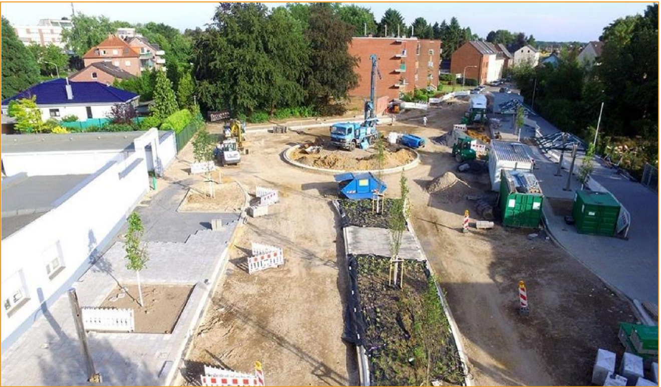
Bau des Zentralen Omnibusbahnhofs
